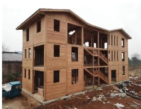
Figura 98. Viviendas en construcción con bambú laminado [16]
