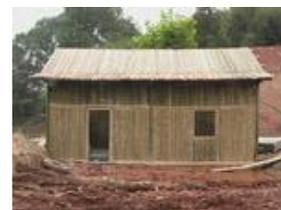
Para zonas de desastres naturales han diseñado y construido una vivienda prefabricada experimental de tableros de bambú, sobre una estructura de madera, con las dimensiones 2440 x 1220 x 50 mm, recubriendo la cara exterior con poliestireno de 9 mm de espesor [5].
