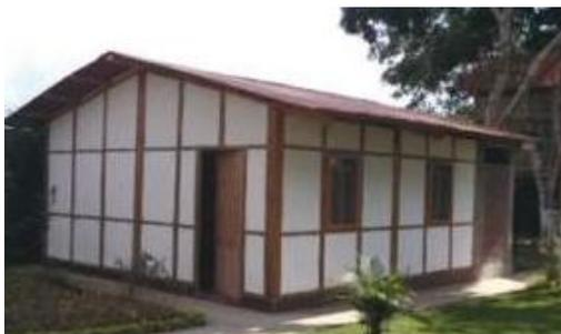
Figura 72. Vivienda con esteras de bambú, madera y mortero
