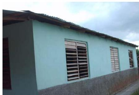
Figuras 12-17. Vivienda de mampostería con cercha y columnas exteriores de bambu y con estructura de madera en los muros interiores, Bayamo, 2008
