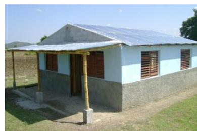
Figuras 18-20. Vivienda de mampostería con cercha y columnas exteriores de bambu en Arrollo Blanco, Guisa, Granma, Proyecto Biomasa-bambú 2010
