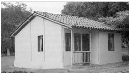
Figura 77. Vivienda construida con la técnica de esteras y mortero en 1994
