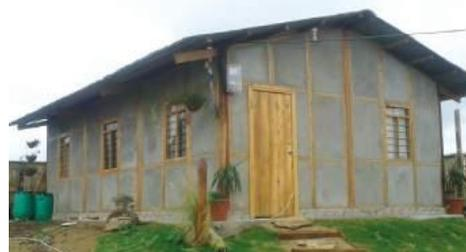
Figura 75. Vivienda con esteras de bambú, madera y mortero
