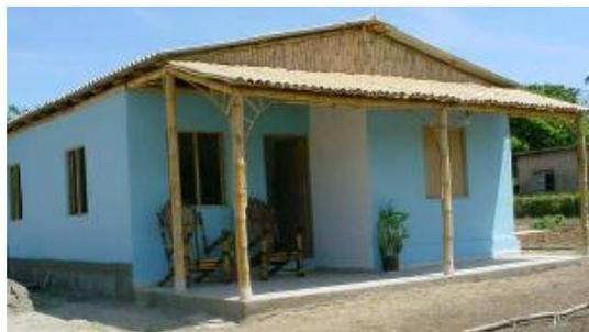
Figuras 4 y 5. Vivienda de esteras de bambú recubiertas con mortero, Holguín, 2010
