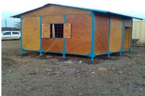
Figura 30. Vivienda prefabricada con tableros tejidos de bambú
