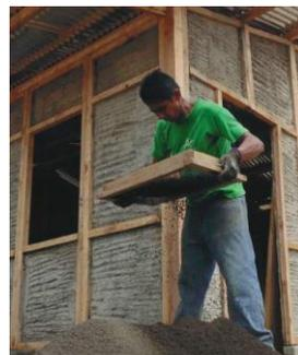
Figura 71. Vivienda en construcción con esteras de bambú, madera y mortero
